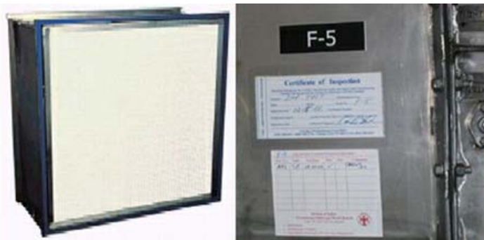
Tubo doble de Aire filtrado por HEPA con monitoreo AP, inspección regular
